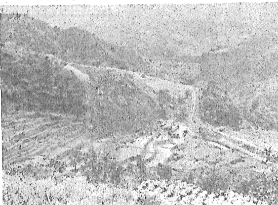
昭和48年6月5日現在 統合中学校敷地造成工事現況
