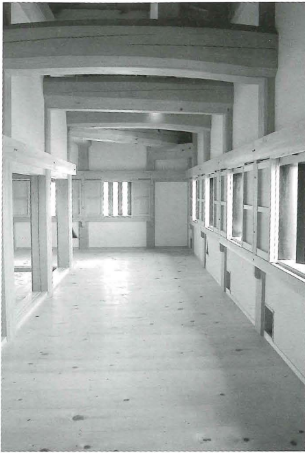
▲大洲城天守の内部。天守に入るとまずこの光景が目に入る。上部に並ぶ大きな丸太梁が特徴。
