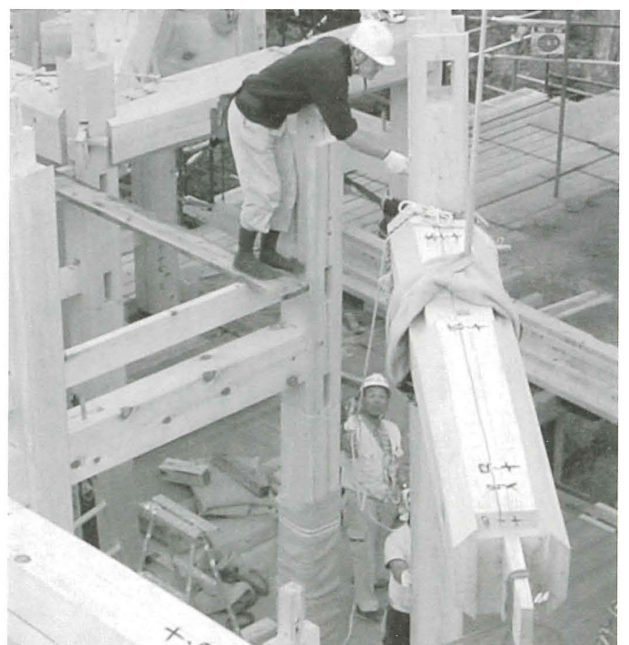
▲柱の上から梁の木組み作業を指揮する永山副棟梁
