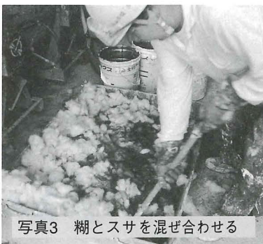
▲漆喰づくりの様子 漆喰塗りは古来からの伝統工法で、製作にも手間がかかる。
