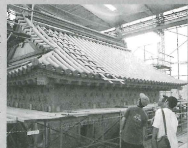
▲4階屋根の鯰瓦や鬼瓦を見上げる見学者
