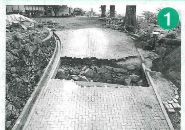
【写真①】 石垣の上部は破壊されているが下部は残存
