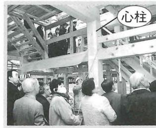
▲1~2階の心柱は御杣始め式で伐採した如法寺の檜を使用(写真中央が心柱)
