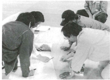
▲設計者と宮大工が原寸図を製作する
