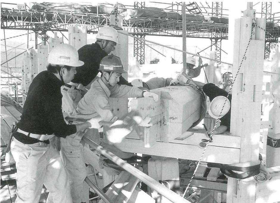
▲富山県井波町の宮大工と地元大洲の技術者たちの見事なチームワーク作業、職人たちが息を合わせ加工した材料を組み立てる
