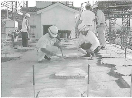
▲土間工事の様子
