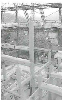
▲天守1階から2階の通し柱
