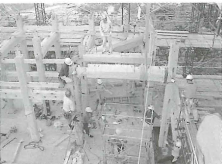
▲建て方工事の様子
