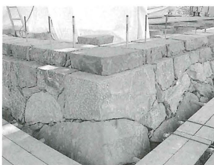
▲石垣工事完了
