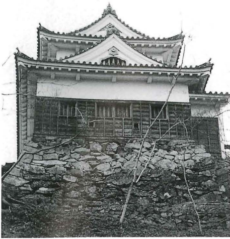
▲台所櫓 一層目に入母屋破風。その下に火灯窓が付けられている。下見板には四角形の鉄砲狭間が備えられている。
