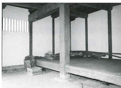
▲台所櫓内部 土間と煙出し用の格子窓がある。
