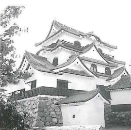
▲彦根城:2,3階に火灯窓がある
