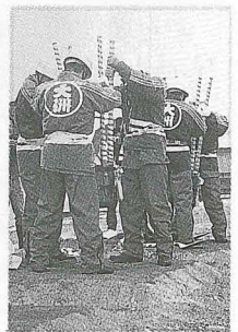
▲水防団による堤防盛り土締め固め
