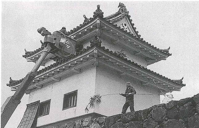
大洲史談会の皆さんが、年末恒例の大洲城櫓のすす払いを行いました。今年は、四電工にも協力いただき、高所作業車を使って学綿櫓の肱川側の壁面も清掃。長年の汚れが落とされ、見違えるほどきれいになりました。
