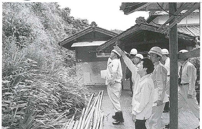
土砂災害防止月間の一環として、大洲土木事務所、警察署、消防署、建設課職員らが、平野・大川・徳森地区のかけ崩れ土砂災害危険箇所をパトロールしました。
