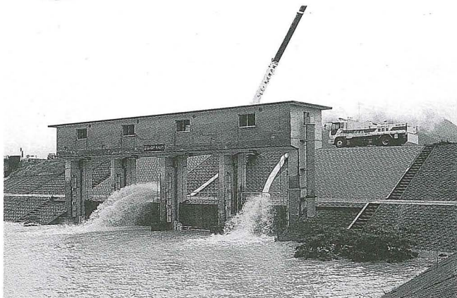
今年4月に建設省大洲工事事務所に配備された排水ポンプ車が初出動し、増水した都谷川の排水作業を行いました。約3時間こわつて毎分60トン排水(計約1万トン)、水位の上昇を抑えました。
