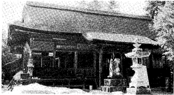
修復が完了した本殿
