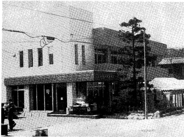
完成した南久米公民館
