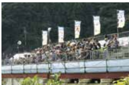
ダム工事用構台上から観覧するみなさん。
