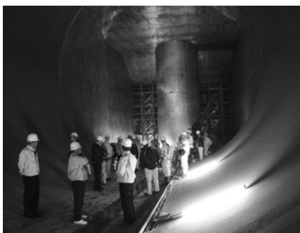
▼産業建設委員会 鹿野川ダム改造事業 (トンネル洪水吐き内)
