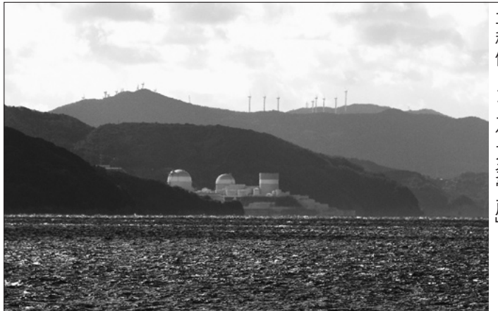
再稼働した「伊方発電所」
