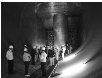
▼産業建設委員会 鹿野川ダム改造事業 (トンネル洪水吐き内)
