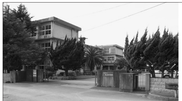
建て替えとなる長浜中学校
