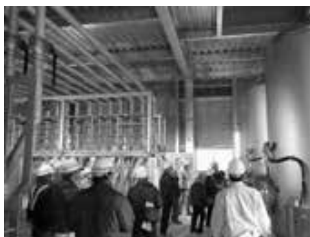
選択取水設備内見学
