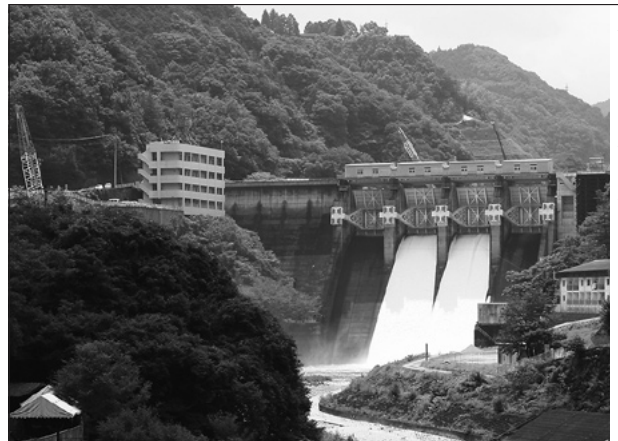
肱川水系河川整備計画に基づき整 備が進む鹿野川ダム改造事業
