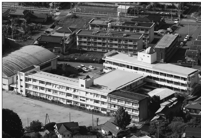
耐震化工事などが実施された校舎 (大洲北中学校)
