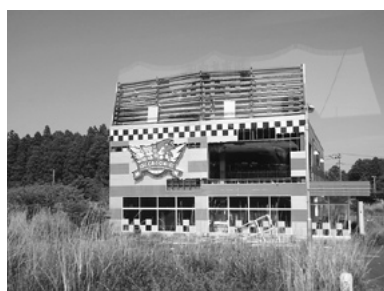
震災当時から放置されている建物(福島第一原発周辺)
