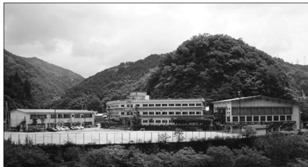
避難対策のため資機材整備を予定している学校施設(肱川中学校)
