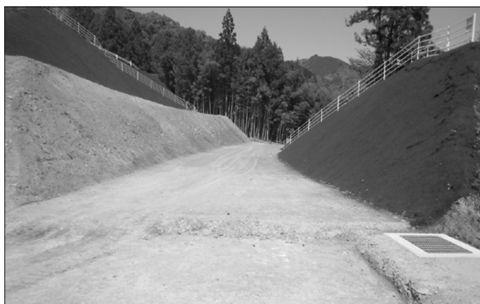
工事が進む付け替え県道
