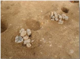
「御長屋」礎石の根固め
