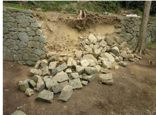
石垣崩落後の状況
