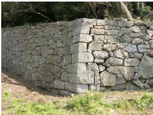
石垣崩落前の状況
