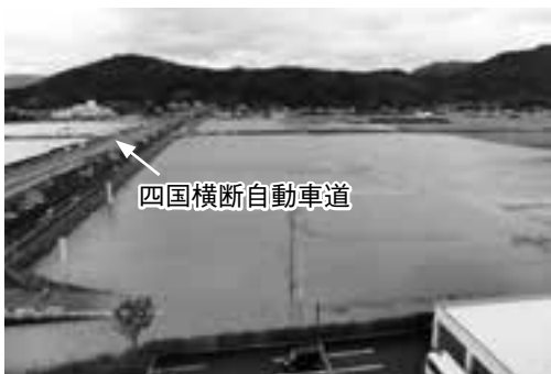
平成23年台風15号による浸水被害(東大洲)
