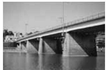
4代目 昭和42年に主桁増設。下流域に向かって2.5mの拡幅が実施された。
