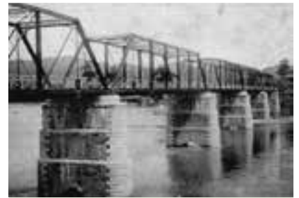
初代 大正2年9月完成。上部工は鋼製の下路トラス橋で、橋脚はレンガ積みであった。
