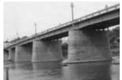
3代目 昭和36年に2車線のプレートガーダー橋に架け替えられた。橋脚はコンクリート製。
