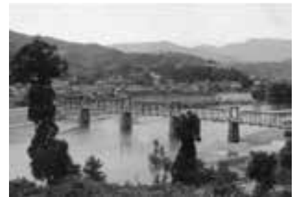
2代目 昭和18年ごろの写真。上部工をケーブルでつる補強が加えられた。
