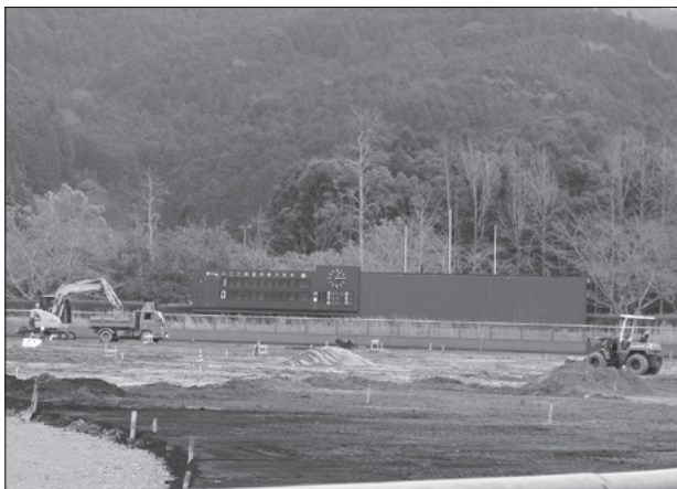
えひめ国体開催に向け整備が進められている野球場（八幡浜・大洲地区運動公園）
