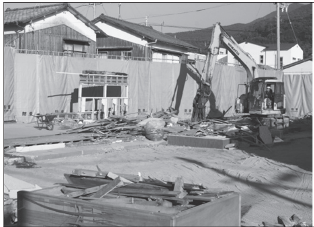
改築に向け解体工事が進む長浜保育所
