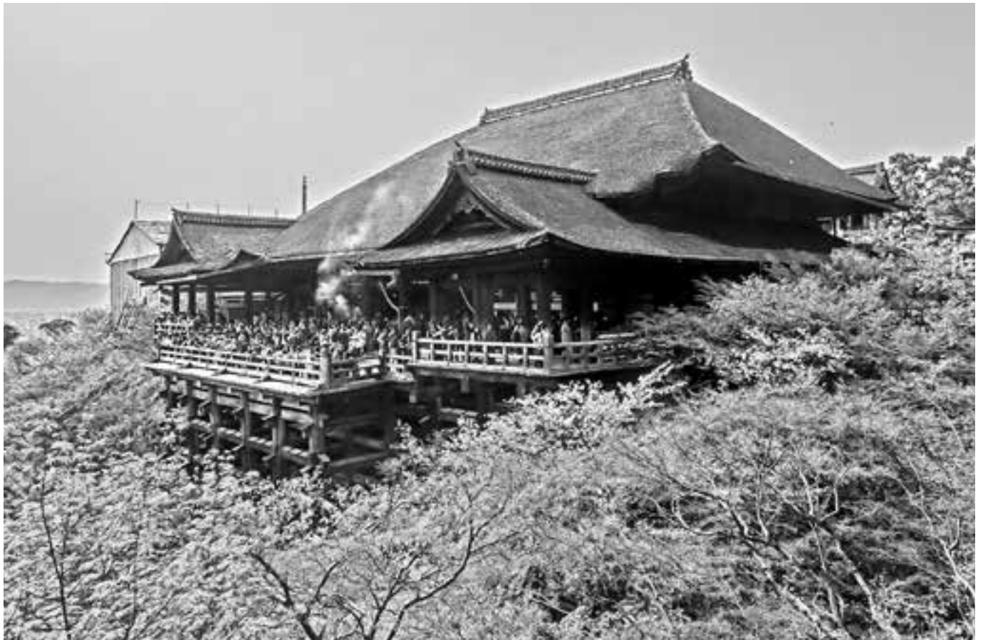
(清水寺本堂：写真提供・河辺中学校)
