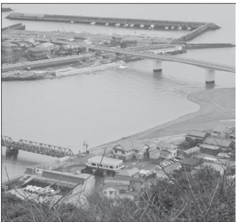
整備が進められている長浜大橋周辺
