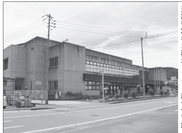
建設後27年が経過している総合体育館
