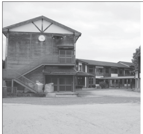
活用が望まれる閉校施設（閉校した小学校施設）
