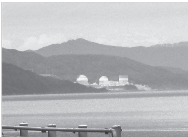
長浜町櫛生から見た伊方原子力発電所
