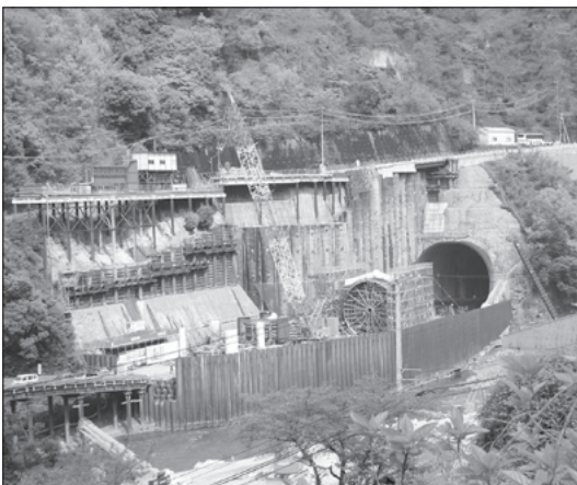
鹿野川ダム改造事業(トンネル洪水吐き工事)
