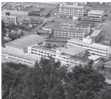
耐震工事が進められる大洲北中学校
