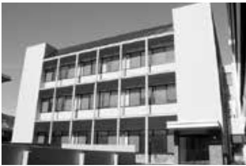
【完成した庁舎別館】
