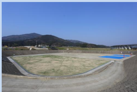
多機能広場(貯留施設)
