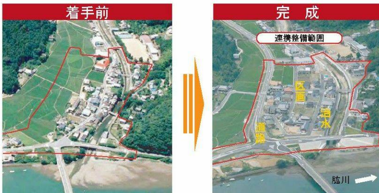
水防災事業、県道整備事業、土地区画整理事業の連携により、安全で快適な住環境の整備が行われました。
