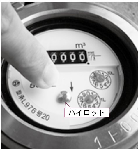
▲水道メーター写真
