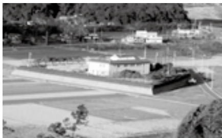
肱南浄化センター
