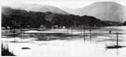
▲マニュアルに掲載された写真 浸水した春賀地区（昭和23年） 肱川とむら 三善生活誌（常磐井忠加著）から
