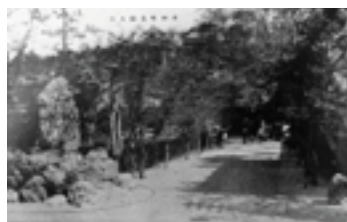
大洲町公園入口
