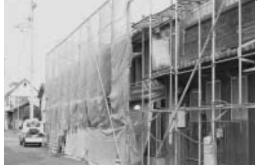
改修後の活用が期待される旧末永家住宅（長浜）
