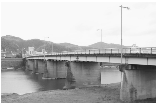
架け替え事業が計画されている肱川橋
