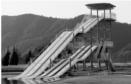
補強工事を行う「スライダープール」
