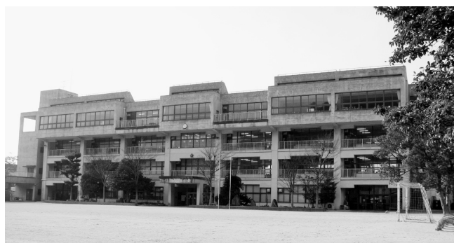
耐震化補強工事予定の長浜小学校
