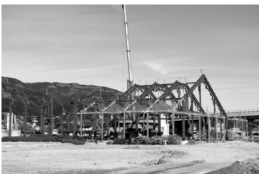
オーブンに向け工事が進む 地産地消拠点施設
