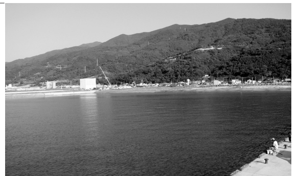
完成が近づいた長浜港小型船だまり
